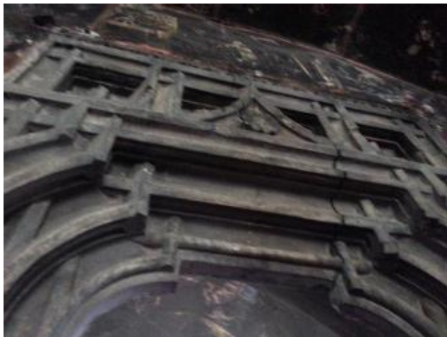
Fig. 56. Portalul studiat. Vedere ascendentă biserica Sf. Gheorghe Câmpulung.
