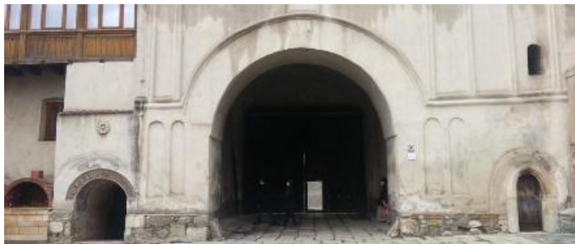
Fig. 6. Detaliu fațada estică a turnului mănăstirii Negru Vodă Câmpulung.
