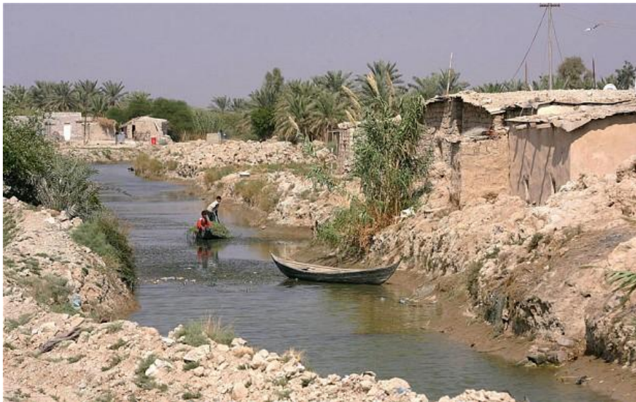
Fig. 2. Case construite din lut. Sursa:
